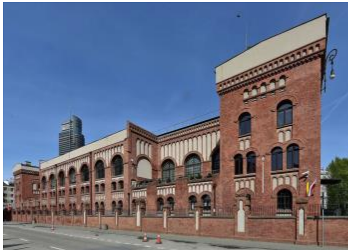
Budynek Muzeum, widok od strony ul. Przyokopowej
